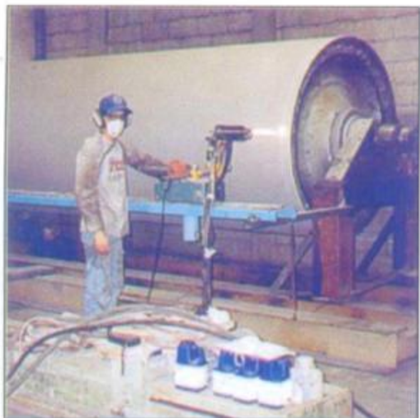
Revestimento em Cilindro secador.
