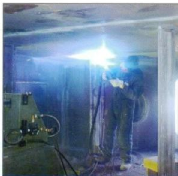
Revestimento anti-corrosivo em estrutura de Ind. Química serviço em campo.
