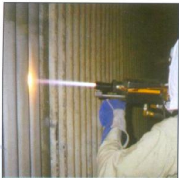
Revestimento em caldeiras no externo do painel.
