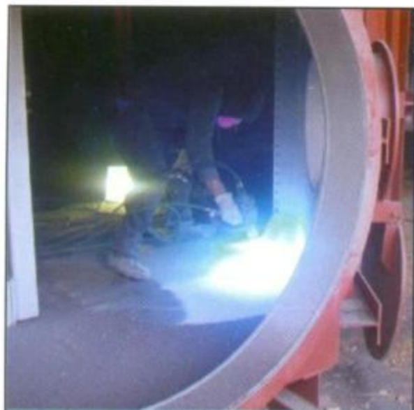
Revestimento contra corrosão em trocador de calor.
