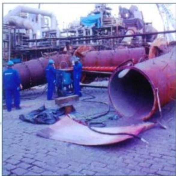
Revestimentos em dutos de gases serviços em campo.
