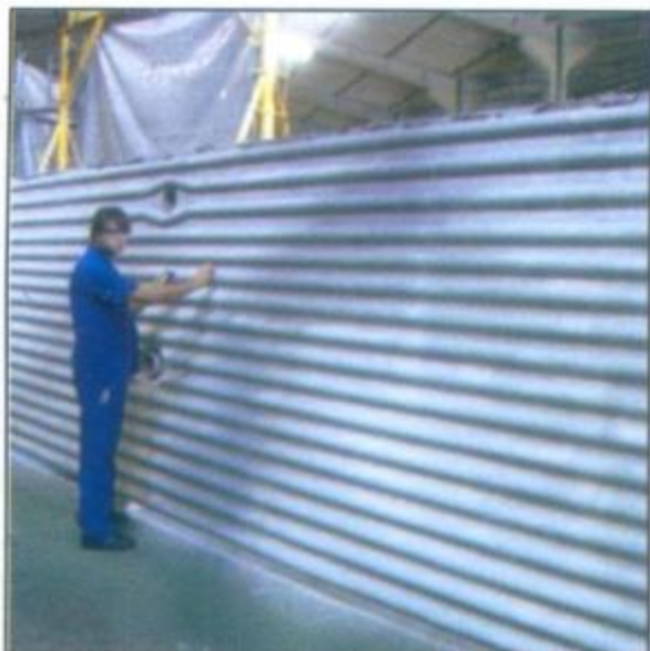
Revestimento contra corrosão em painel.
