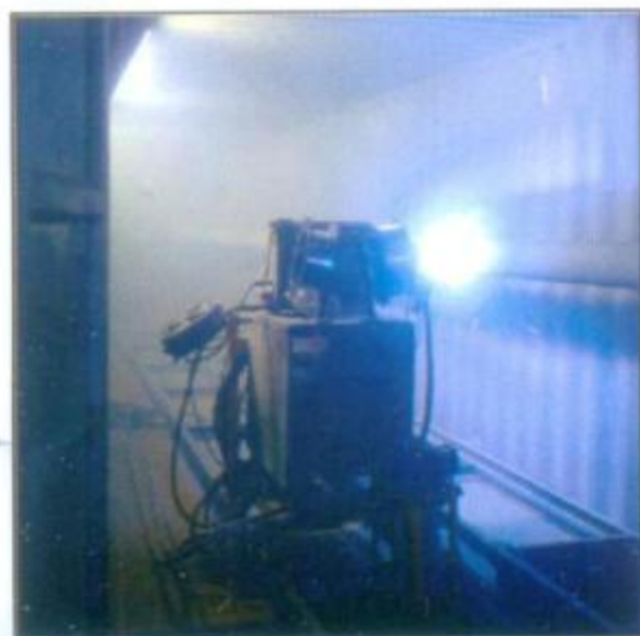
Revestimento externo em tubos de diversos diâmetros e comprimentos..
