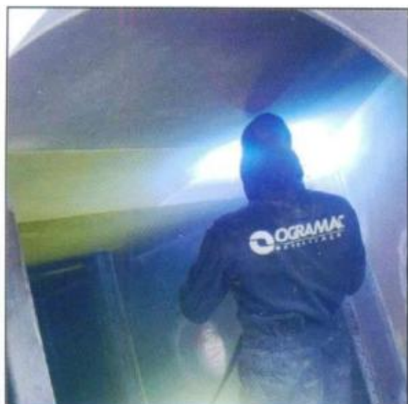
Revestimento em estruturas diversas serviço em campo.
